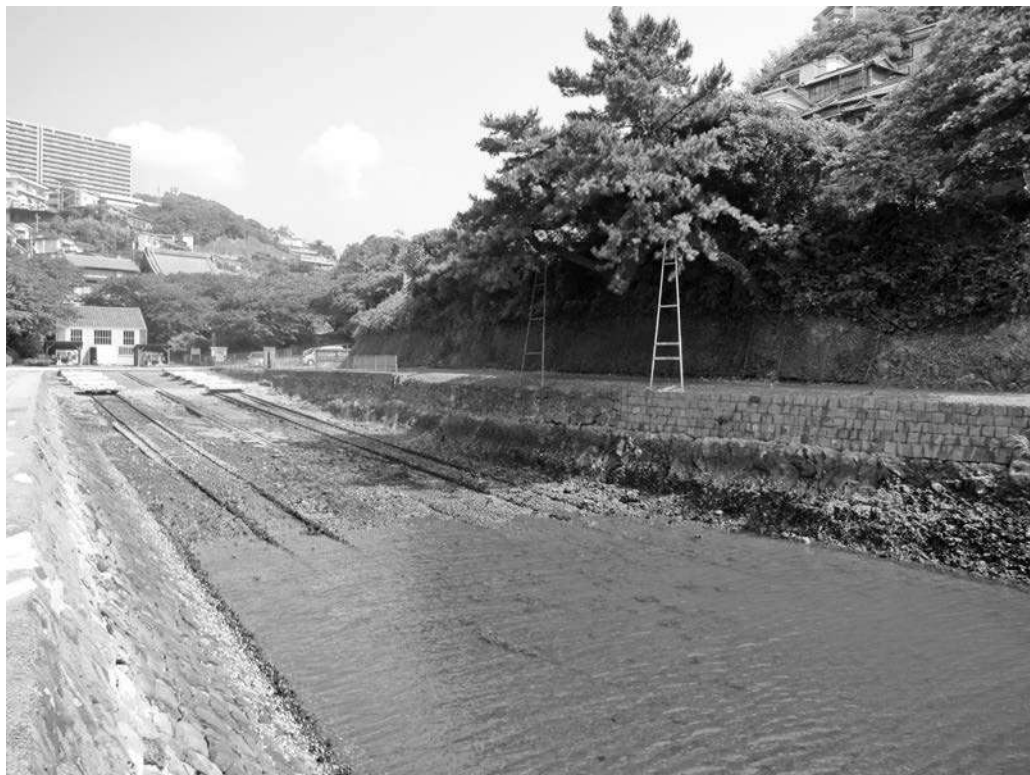
図 4-1 長崎小菅修船場の現況，斜路と両岸の石垣，引揚げ機小屋（1869 年完成）（2010 年 5 月 筆者撮影）
